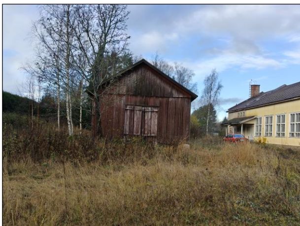
Rakennusten lisäksi tehdastontilla on laaja, ruohottunut pihamaa.
