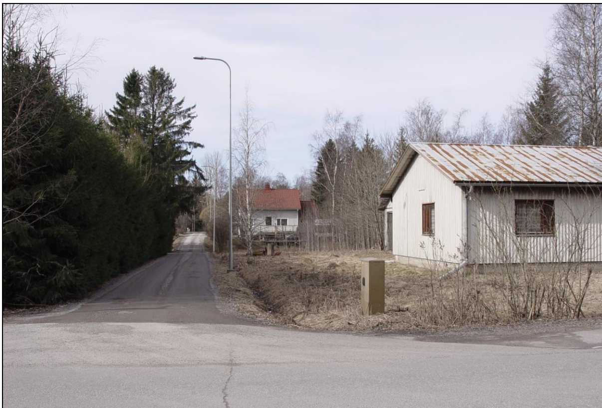
Lahnojankuja erkanelee suorakulmaisesti Sillankorvantieltä. Tieväylä on vanhaa perua, joten kiinteistöt ulottuvat asemakaavan mukaiselle katualueelle. Seurauksena muun muassa kookas kuusialta kasvaa aivan kadun laidalla.
