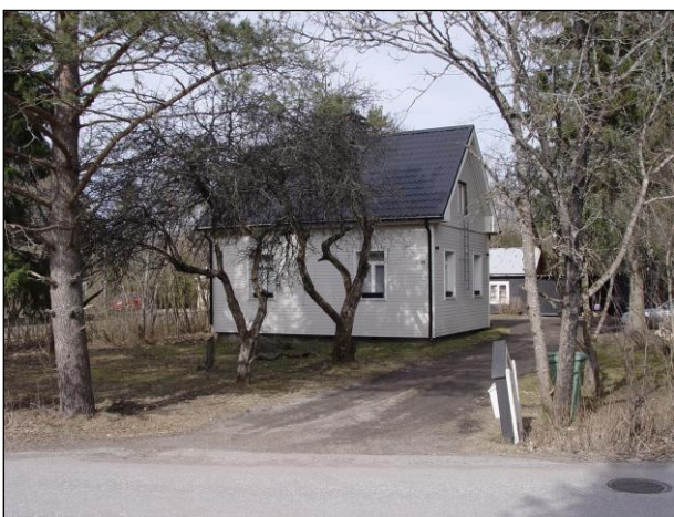
Inkilän kiinteistöllä (19-423-2-46) on 1930-luvulla rakennettu asuinrakennus ja talousrakennus. Pihapiiri on osa Sillankorvantien raittiasutusta.
